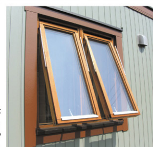
気密性・断熱性に優れた 重厚な木製トリプルガラスサッシ。 180度回転させれば、室内に居ながら 掃除やメンテナンスも容易。
