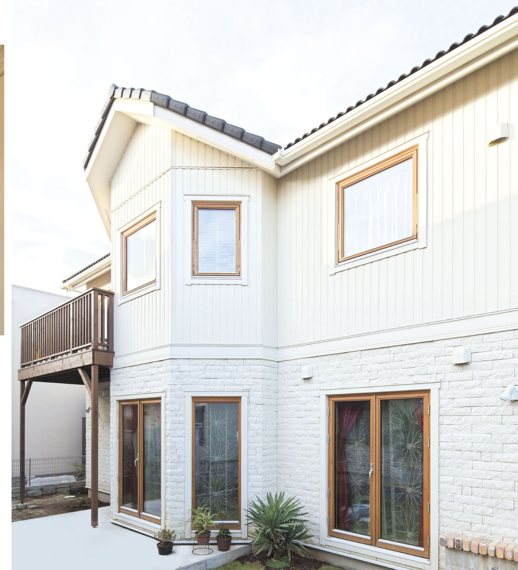
中央部の張出しが特徴的な外観。1・2階であえて質感を変えた白い外壁は、木製3層ガラスサッシがアクセントに。芝生(外構は建築途中)の緑にも映える。
